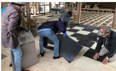
タイルカーペットの敷き込み作業
